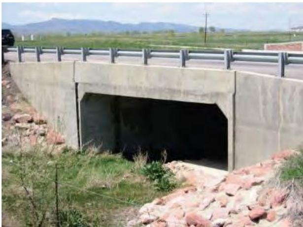
图 7-2 混凝土箱涵（from FHWA, 2012）
