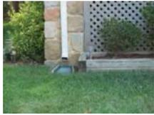
屋顶隔断具有落水管排向渗透性景观区域和草坪，而不是直接进入雨水管。它也可以模拟直接连接并溢流到渗透面积的排水管的屋顶。
