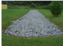
渗渠为填有砂砾的窄渠，截除来自上部坡度不渗透面积来的径流。它们提供了蓄水容积和捕获径流的额外时间，为了下渗到本地土壤。
