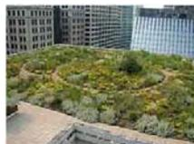
绿色屋顶为另一类生物滞留网格，它在特殊排水垫层之上具有土壤层，输送屋顶过分差穿透的降雨。
