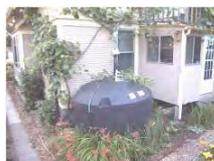
雨水桶（或水窖）为收集降雨期间屋顶径流的容器，可以在旱季排放或回用雨水。
